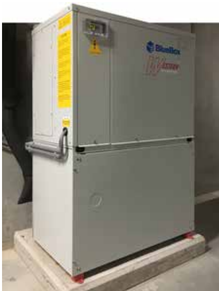
De water/water-warmtepomp (Western MU Echos A) in de kelder, voor de koudelevering van de kantoren en het horecagedeelte.
