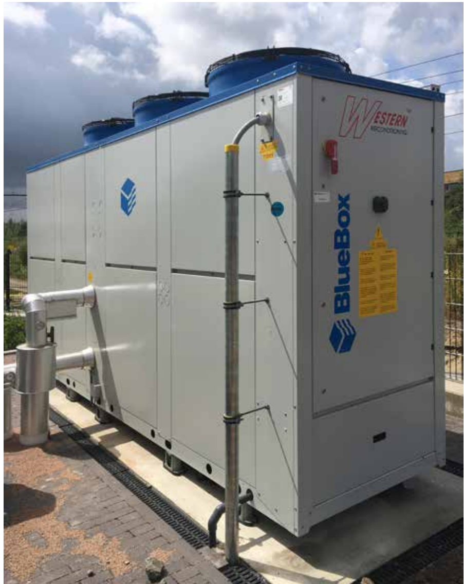
Eén van de twee ZETA REV HE HP 13.2 (high efficiency) lucht/water-warmtepompen met een totaal opgesteld verwarmingsvermogen van 300 kW, waarmee het zwembad op temperatuur wordt gehouden, de luchtverwarming plaatsvindt en deels in de voorverwarming van het tapwater wordt voorzien.
