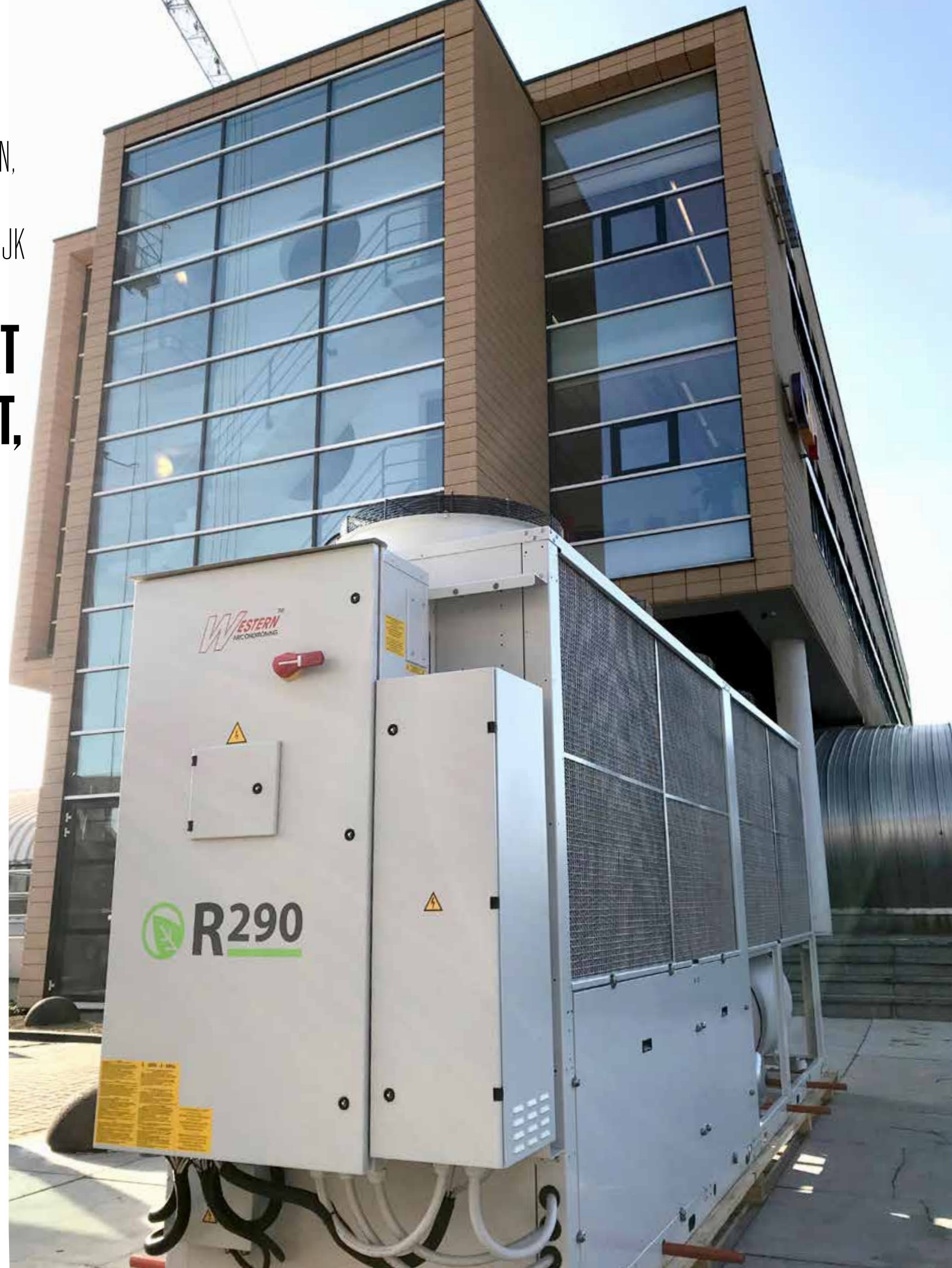
Western luchtgekoelde inverter waterkoelmachine voor bloembollenmakelaar CNB.
